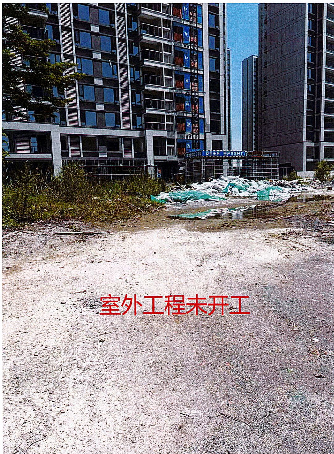
附件5：黄山村安置房项目(一期)南区小区高层住宅二次供水设施委托建设管理工程-清工施工现场照片
